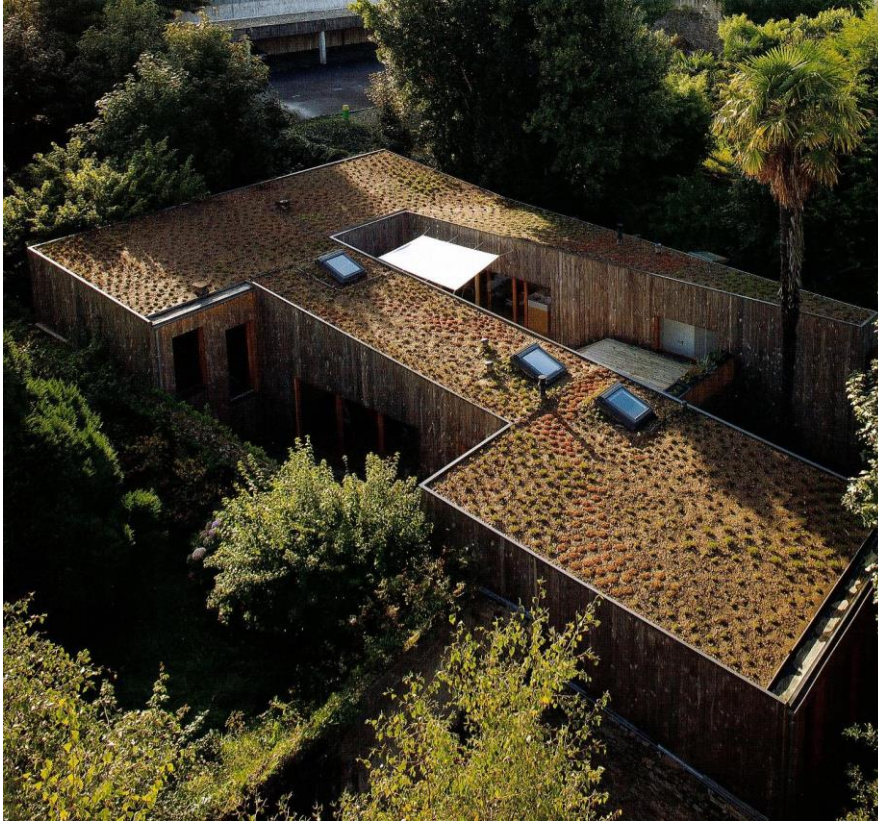
Toiture terrasse (photo illustrative) – Maisons siamoises – PO Architectes – Nantes.
