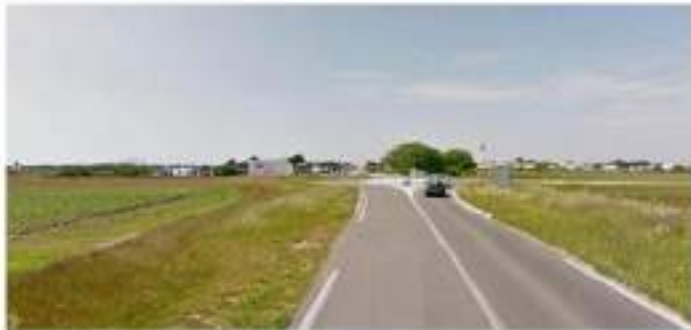
>>>> SITUATION EXISTANTE (DEPUIS LE GIRATOIRE)
