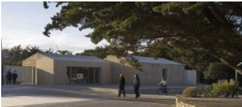
Pavillon d'accueil Clémenceau – Titan architectes
