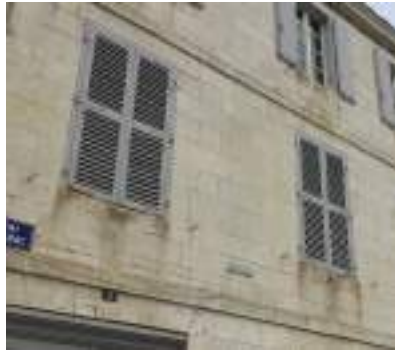
Façade en parement de pierre calcaire
