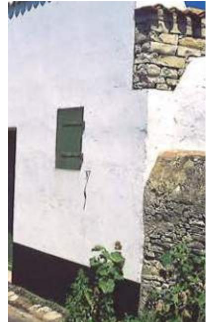
Mur de moellons avec un enduit couvrant
