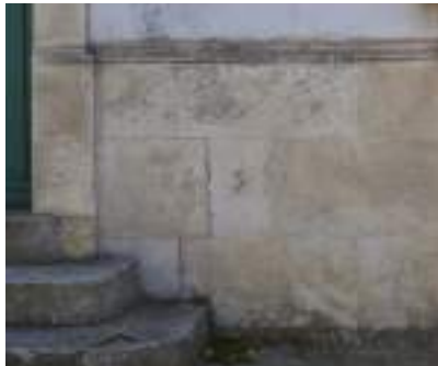
Soubassement en pierre de taille calcaire
