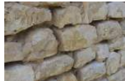
Pierres sèches appareillées
