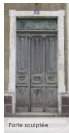
Porte à 2 vantaux avec imposte vitrée
