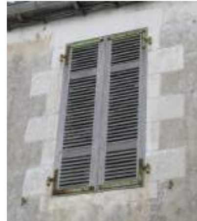
Encadrement de baie en pierre calcaire
