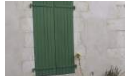
Mur de moellons avec un enduit couvrant
