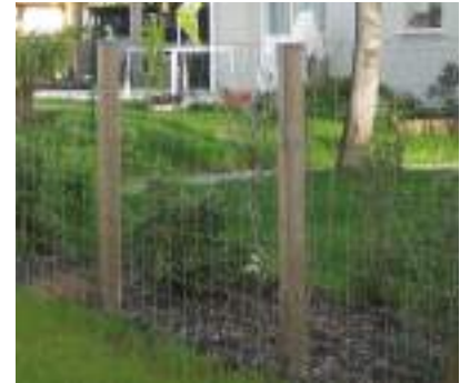
Exemple d'une clôture galvanisée sur poteaux bois
