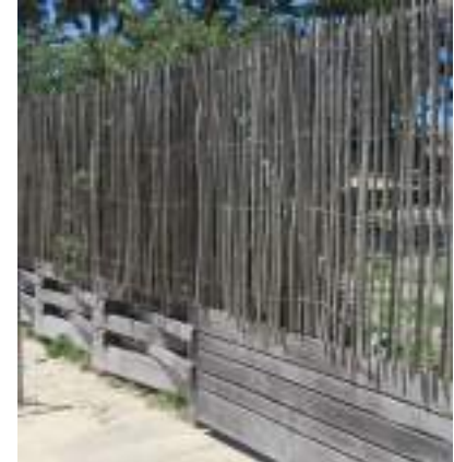
La Couarde-sur-Mer Clôture en ganivelles et soubassement bois
