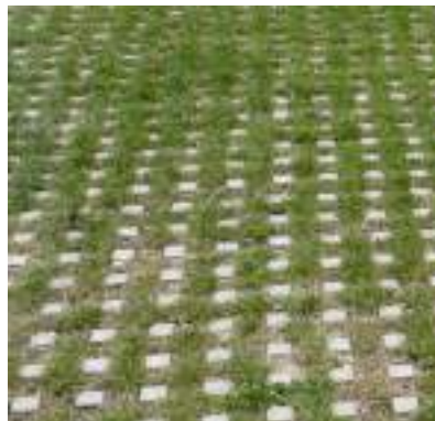
Pavés à joints engazonnés
