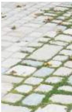
Pavés et dalles à joints engazonnés
