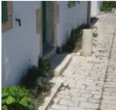
Ile-de-Ré Rue végétalisée : vivaces dans fosses de plantation
