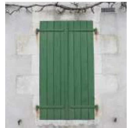
Encadrement de baie en pierre calcaire
