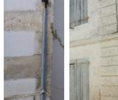
Chaînage d'angle et pilastre
