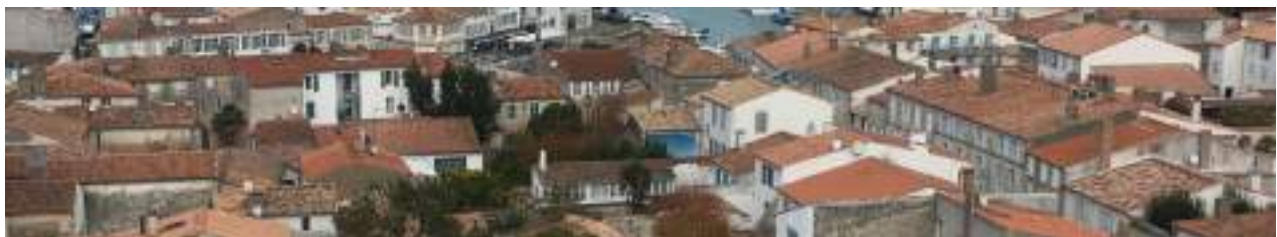
Toitures en tuiles canal
