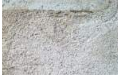
Enduit traditionnel chaux et sable
