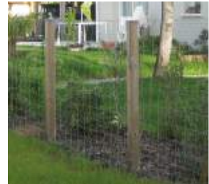
Exemple d'une clôture galvanisée sur poteaux carrés
