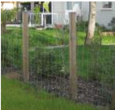
Exemple d'une clôture galvanisée sur poteaux carrés
